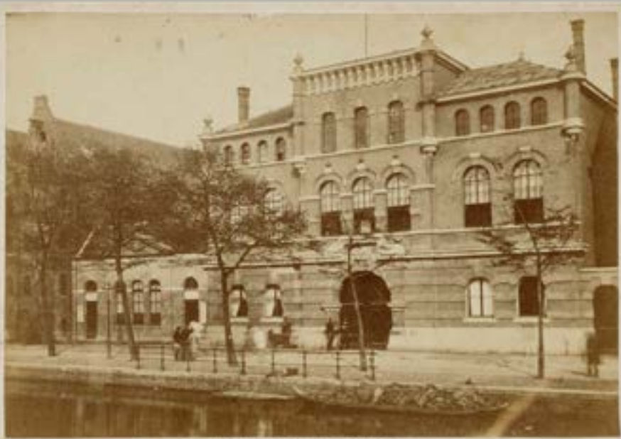
Foto van Prinsengracht 235 en 237 die vermoedelijk kort na de verbouwing tot brandweerkazerne in 1874 is genomen. Prinsengracht 235 was aanvankelijk uitgevoerd met twee smalle zijingangen (Stadsarchief Amsterdam, Beeldbank, inv.nr. 010005001698)
